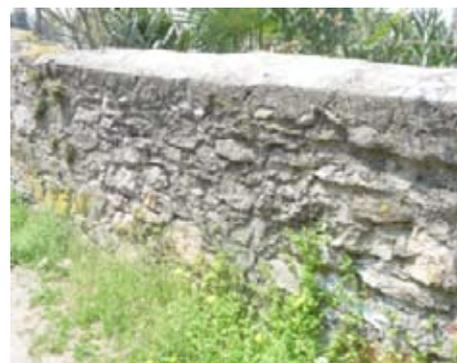
Il muro è stato consolidato utilizzando un legante a base di calce aerea per limitare gli interventi di manutenzione. La soluzione è accettabile: i giunti di malta non alterano troppo la morfologia originaria. Tuttavia il muro è stato dotato superiormente di un corridoio cementizio, preferibilmente da evitare.
