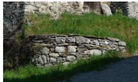
Muro a secco originario, con funzione di contenimento e delimitazione di pianoro
